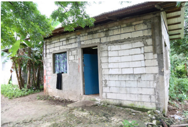
一見すると被害がなさそうに見える家屋ですが、手前の壁を手で押すと屋根の部分と接合されておらず、壁全体が前後に大きく揺れてしまいます。住民は避難しています。©CWS JAPAN
