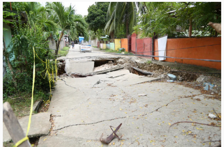
地震により陥没した生活道路。セブ島北部のサン・レミジオ町にて。©CWS JAPAN
