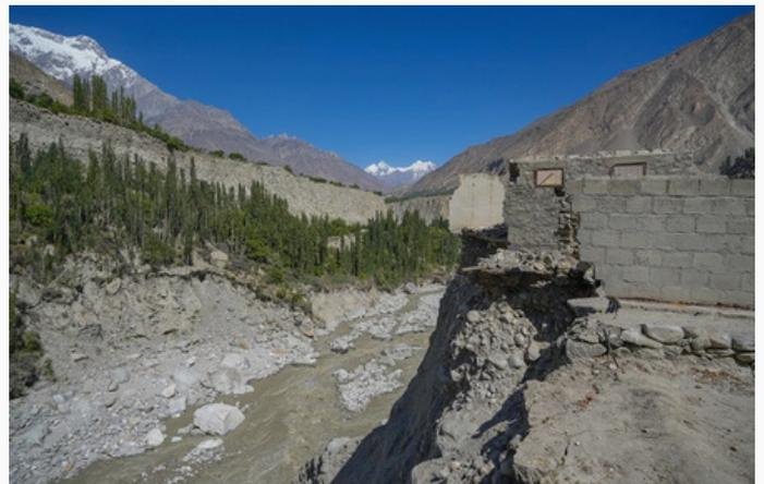
河川の増水による河岸侵食で、住宅の土台が流されて損壊した家屋。まるで地震のような揺れが起こり、家の一部が流されたと、避難した住民は報告した。
