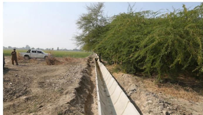
完成間近の灌漑用水路。できるだけ直線系のV字溝にすることで流水速度を早めることができるため、滞留物の沈殿が少なくなり、結果としてメンテナンスしやすく、越水のリスクも軽減できます。©CWS Japan
