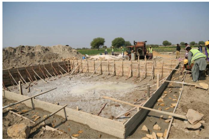
建設途中の貯水池。インダス川を源流とする運河の水を各村の用水路に取水できる期間には制限があります。水を貯めることができると、そうした取水期間に捉われることなく、より必要な時に効率的に水資源を利用することが可能になります。貯水池の水は畑だけでなく苗床の育成にも利用されます。©CWS Japan
