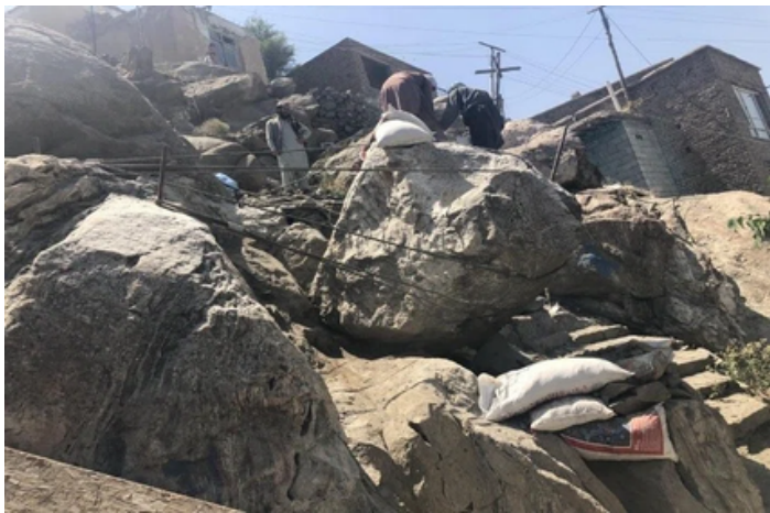
不安定な巨礫を取り除く際にロープで固定している様子©CWSA
