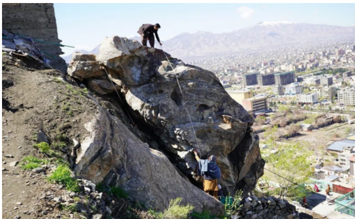
カブール市内で落石対策をしている現場©CWSA
