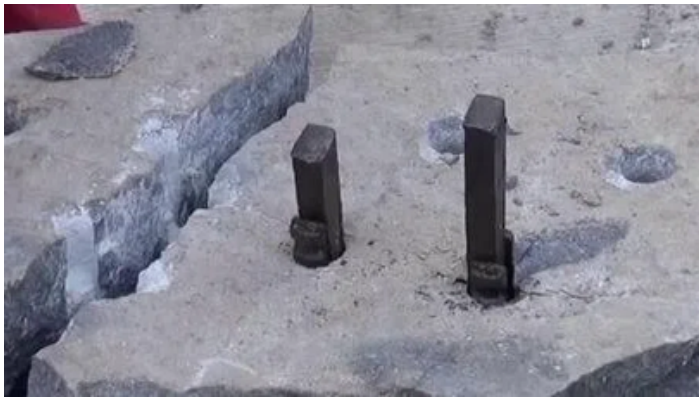
岩にくさびが打ち込まれた様子©CWSA
