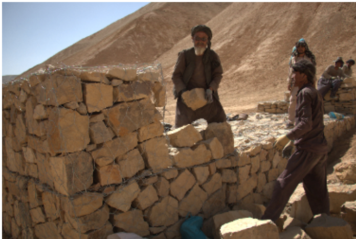
蛇籠を積み上げ、石を入れていく様子 ©CWSA
