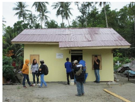
Jono村で建設した仮設住宅
