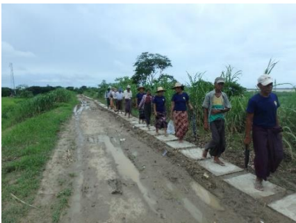
改善工事が終了した道を住民と共に歩く
