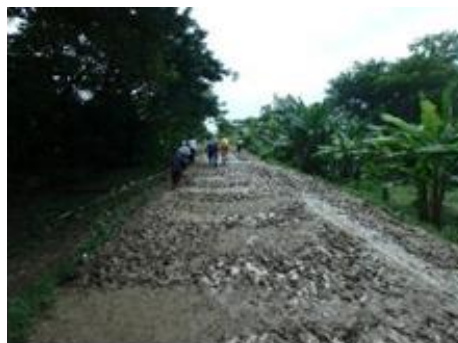
これから住民の力で修復していくコミュニティの生活道路
