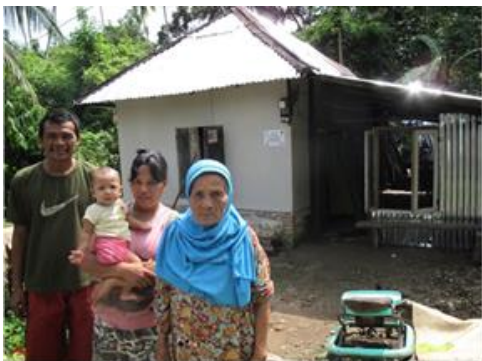
CWSが過去にインドネシアで設置した同型の仮設住宅
