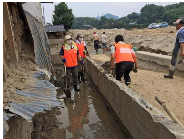
朝倉市杷木東林田地区での作業の様子
